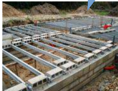
Dalle intérieur sur hourdis Et vide sanitaire
