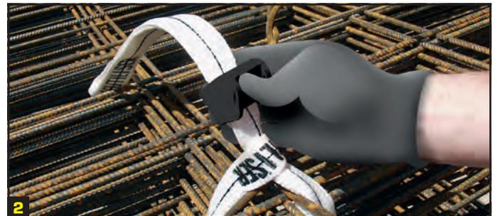
Faire coulisser l'ensemble au maximum, le plus près possible du paquet de treillis. Verrouiller le système Li-1 en appuyant sur la partie supérieure de la pièce. Enfoncer le poussoir jusqu'au "CLIC".
