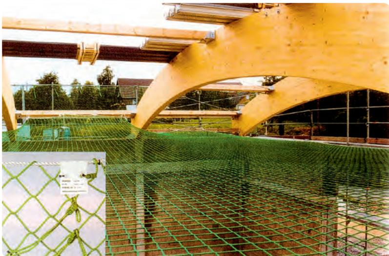
**Filet de sécurité conforme à EN-1263-1, type S**
