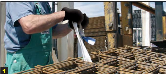
Réaliser le passage de l'élingue dans les mailles des treillis soudés. Passer l'extrémité d'accrochage de l'élingue dans la boucle. Enfiler la sangle dans la pièce plastique Li-1, en respectant le sens de la flèche sur le boîtier.
