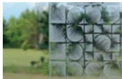
Vue de l'intérieur vers l'extérieur
