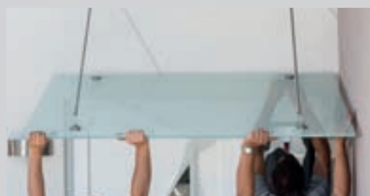
6 / Positionner la dalle sur les ancrages muraux bas et haubans puis visser les 4 fixations à œillet avec une clé à 6 pans
