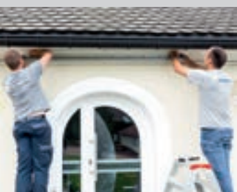
1 / Percer les trous et adapter la fixation en fonction du support puis monter le profilé contre le mur
