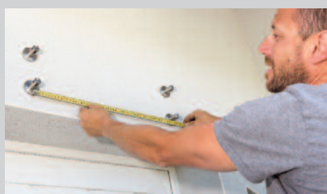
2 / Visser les fixations murales avec œillet sur la tige filetée
