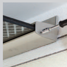
5 / Coller les embouts de finition et les visser.
