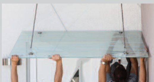
6 / Positionner la dalle sur les ancrages muraux bas et haubans puis visser les 4 fixations à œillet avec une clé à 6 pans
