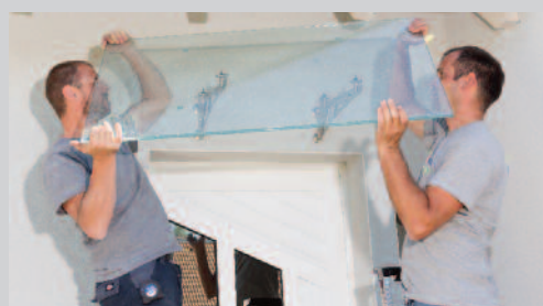
4 / Poser et ajuster le panneau de verre percé sur les consoles
