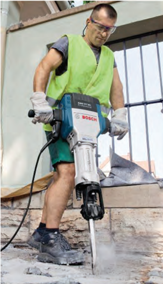
Pour le béton
